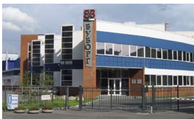
Центр «Буборг» СПб, ул. Кузнецовская, д. 52 Заказчик: ООО «СТЭП» Виды выполняемых работ: Полный комплекс электромонтажных работ. 2002-2003 гг.
