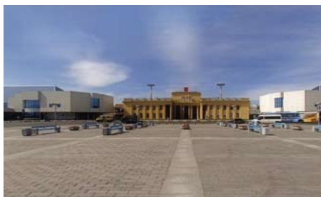
Пулково-1, Пулково-2 Заказчик: ФГУАП «Пулково» Виды выполняемых работ: Полный комплекс проектных и электромонтажных работ по строительству международ- ного аэровокзального комплекса (МВК); электромонтаж- ные работы по реконструкции существующих помещений и наружных сетей старого АВК «Пулково II»; реконструк- ция ГРЩ-1, ГРЩ-2 и ТП-76 АВК «Пулково II»; освещение привокзальной площади АВК «Пулково II»; освещение фасада АВК «Пулково I»; полный комплекс проектных и электромонтажных работ по реконструкции АВК «Пулко- во I»; полная реконструкция действующих ТП-31, ГРЩ-1 и ТП-32, ГРЩ-2 в АВК «Пулково I». 1995-2007 гг.
